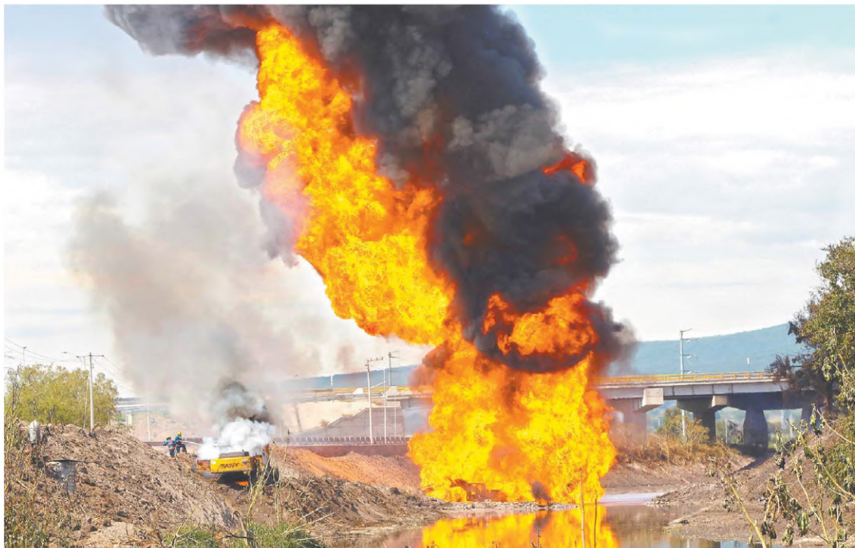
A las 9:45 horas de ayer ocurrió una explosión, cuando una máquina retroexcavadora hizo contacto con uno de los ductos de Pemex, según autoridades.
