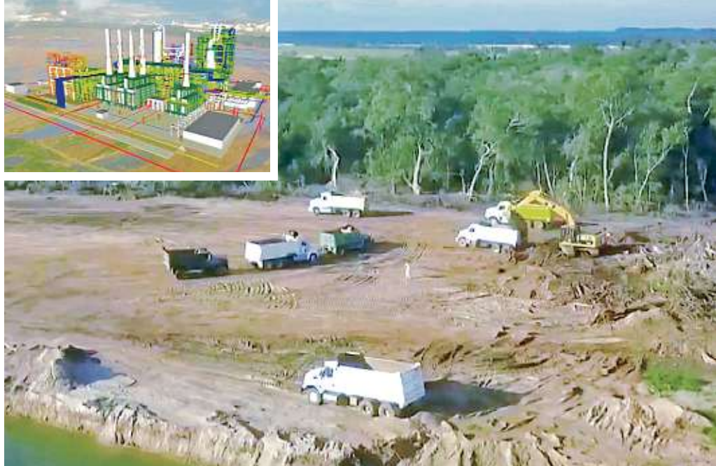
El Gobierno federal declaró ayer iniciados los trabajos de acondicionamiento de terrenos donde se construirá la refinería de Dos Bocas; arriba, la proyección de la obra terminada.
